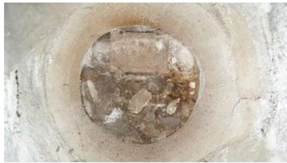
Kuva LVI-29. Kuva kellarin käytävän lattiasa olevasta viemärin tarkastusluukusta.
