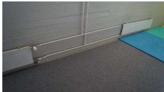
Kuva LVI-9. Kellaritiloissa lämmitysputket ovat ilman eritettä pattereille kytkettäessä.
