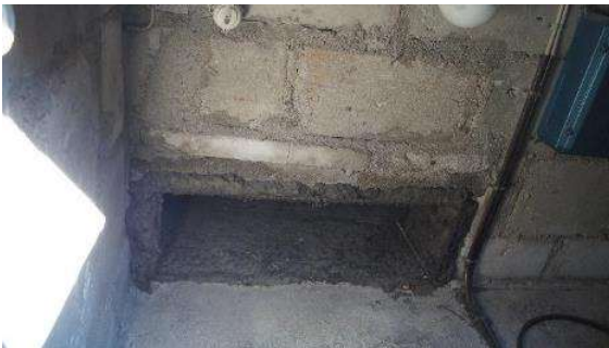
Kuva LVI-53. Kellarin kanavat ovat osittain näkyvissä. Kanavat ovat kanttikanavia pyöristetyin kulmaosin.
