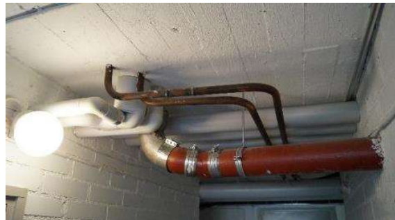
Kuva LVI-31. Vanhaa pinnoitettua valurautaa vasemmalla ja uusi valurautaviemäri oikealla puolella (punainen putki) kellarin katossa.
