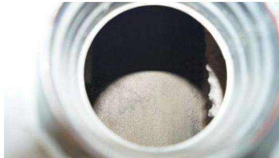
Kuva LVI-54. Nousukanavat ovat betonihomeja.
