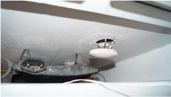
Kuva LVI-59. Osassa asuntoja on vielä käytössä keittiössä vanhoja kylmäkomeron venttiilejä raitisilmaventtiileinä.
