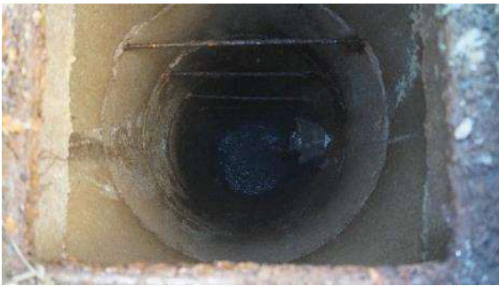
Kuva LVI-28. Kuva talon päädyllä olevasta viemärin betonikaivosta. Kaivonrenkaat ovat tiiviit ja kohdallaan.
