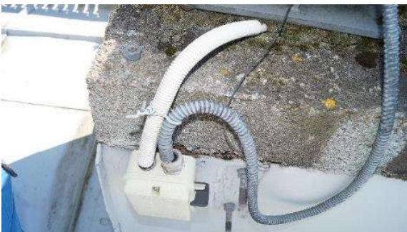
Kuva LVI-49. Kuva takkaimurin turvakytkimestä kaapelointineen. Kaapeliläpiviennit eivät ole vesitiiviitä.
