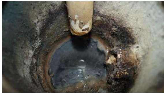
Kuva LVI-41. Alkuperäinen lattiakaivo, joka sisäpuolisesti saneerattu pinnoittamalla.
