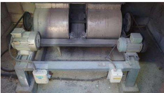
Kuva LVI-49. Kuva takkaimurin turvakytkimestä kaapelointineen. Kaapeliläpiviennit eivät ole vesitiiviitä.
