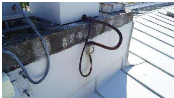
Kuva LVI-50. Kuva takkaimurin turvakytkimestä kaapelointineen. Kaapeliläpiviennit eivät ole vesitiiviitä.
