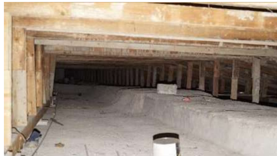
Kuva LVI-54. Nousukanavat ovat betonihomeja.
