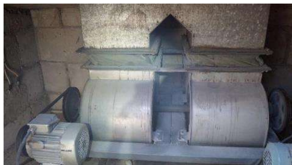
Kuva LVI-50. Kuva takkaimurin turvakytkimestä kaapelointineen. Kaapeliläpiviennit eivät ole vesitiiviitä.
