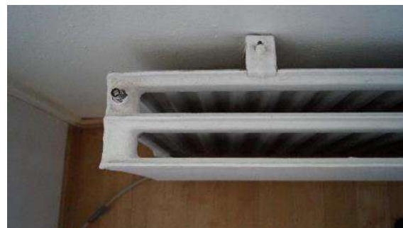
Kuva LVI-15. Kuva patterin yläpuolelta, kulmakannake. Ilmausruuvi on uusittu perussäädön yhteydessä 2012.
