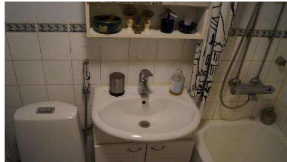
Kuva LVI-39. Kuva kylpyhuoneen wc-istuim, pesuallas ja hana bidettalla, ammehana.
