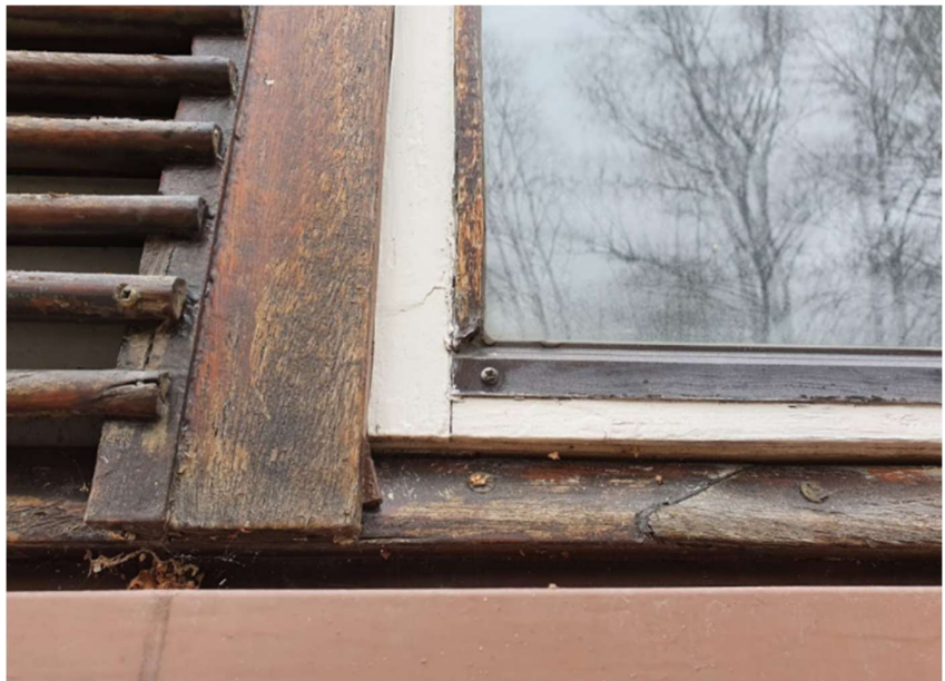
Ikkunoiden puitteiden sisäosissa esiintyy vaihtelevaa maalin hilseilyä.
