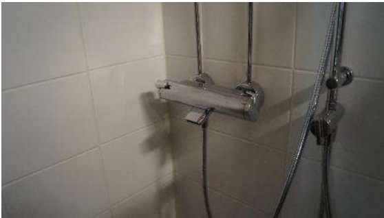
Kuva LVI-38. Kylpyhuoneen suihkusekoittajat ja suihkusetit on uusittu 2010.
