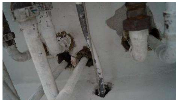
Kuva LVI-11. Kuva porrashuoneen kellaritasolla olevista lämpöjohtojen nousulinjoista, jotka ovat eristettyjä teräsputkia.
