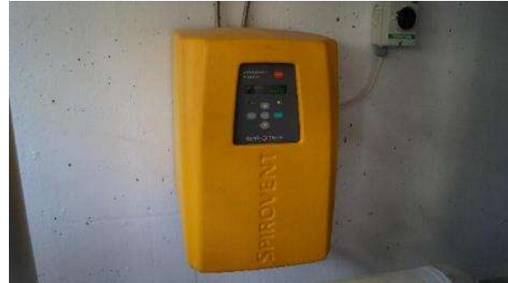
Kuva LVI-7. Kuva lämmitysverkostoon asennetusta mikrokuplanpoistimesta (ilmanpoistaja) Spirovent S4.
