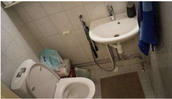
Kuva LVI-40. Kuva erillis wc-tilasta, jossa vesi- ja viemärikausteet on uusittu 2010.
