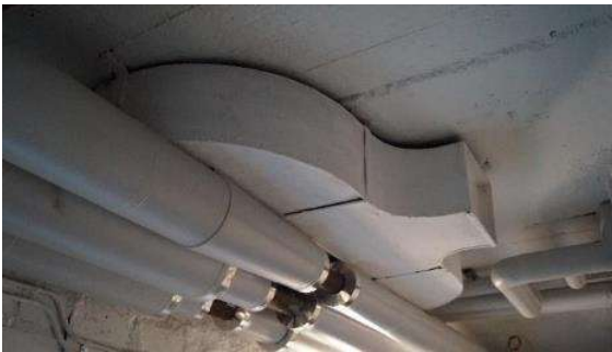
Kuva LVI-53. Kellarin kanavat ovat osittain näkyvissä. Kanavat ovat kanttikanavia pyöristetyin kulmaosin.
