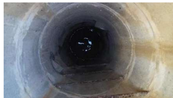
Kuva LVI-37. Kuva sadevesien betokaivosta. Kaivon renkaat näyttävät olevan kunnossa ja saumat niin ikään vaikuttavat olevan kunnossa.
