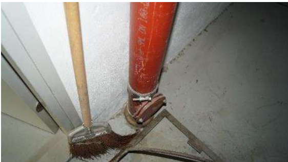
Kuva LVI-30. Kellarissa valurautaviemärit uusittu näkyvin osin, puhdistusluukut uusia.
