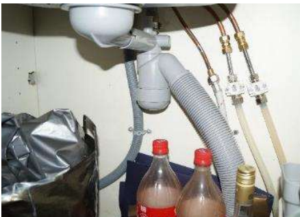
Kuva LVI-26. Kuva keittiöhanan kalustekohtaisista sulkuventtiileistä.
