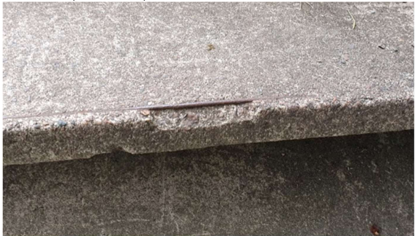
Pihan betoniportaissa on paikallisia teräskorroosiovaurioita/lohkeamia
