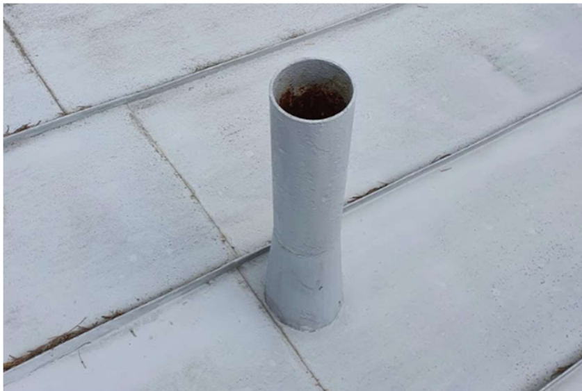
Yksittäisestä viemärin tuuletusputkesta puuttuu pakkasmantteli/T-haara.
