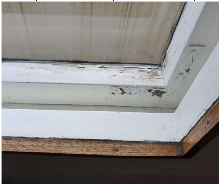
Ikkunoiden puitteiden sisäosissa esiintyy vaihtelevaa maalin hilseilyä.
